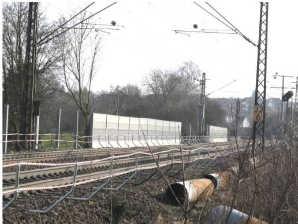
Lärmschutzwand in Bau westl. Hampfergrundweg
