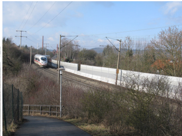
Lärmschutzwand östl. Hampfergrundweg
